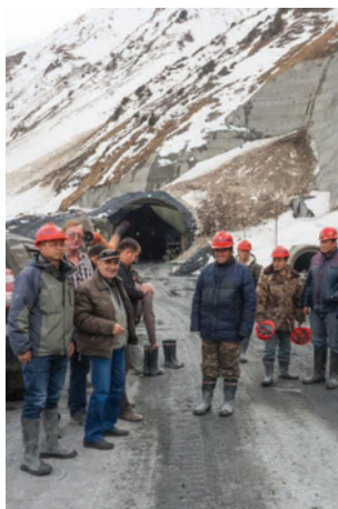
На объекте – тоннель Кок-Арт
